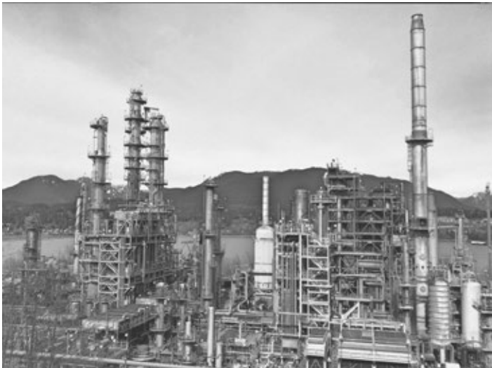
Refinería de petróleo. Las columnas altas son torres de destilación.
